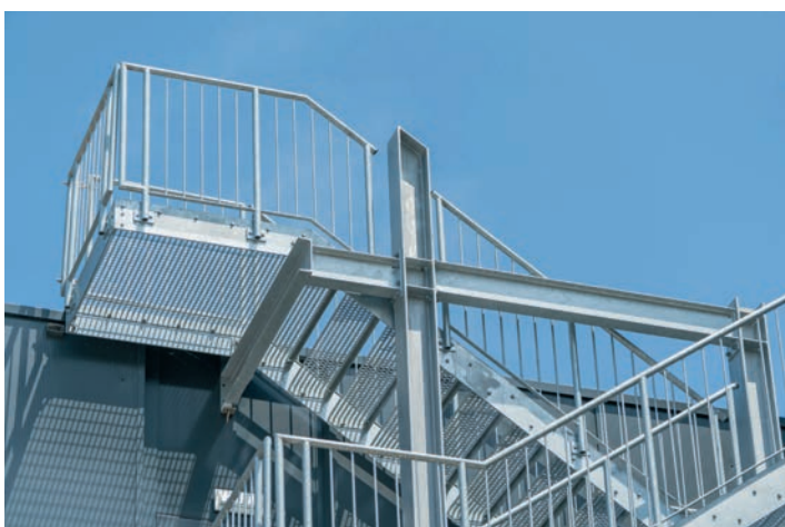
Statik, Ausführungsplanung, Herstellung und Montage erfolgten komplett durch Sprich.
