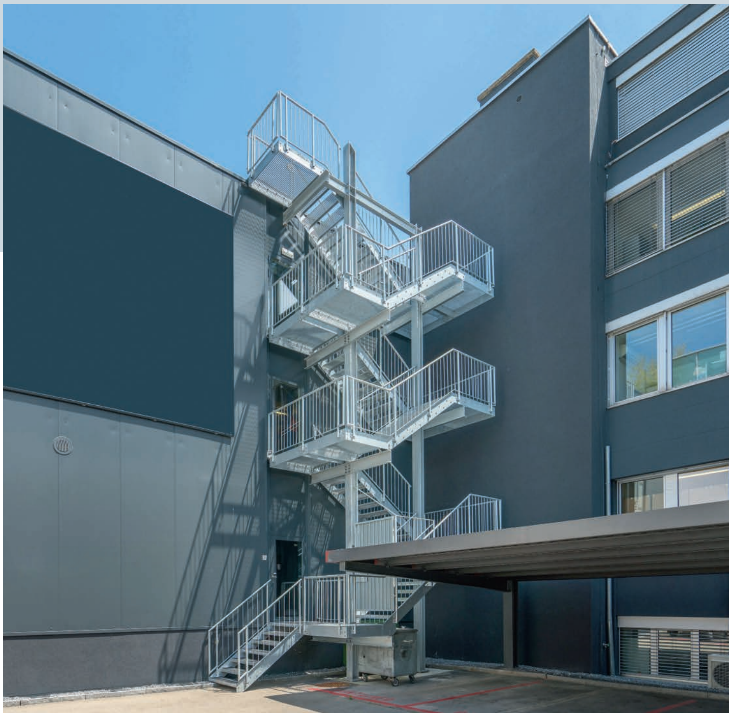
Der mit Gitterrosten belegte Treppenturm erschliesst vier Geschosse und misst 12 Meter in der Höhe.
